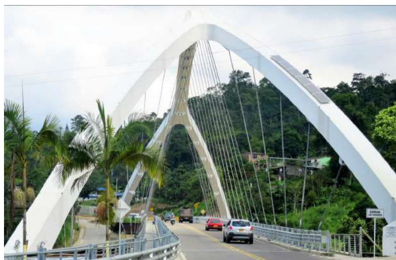
El puente Bicentenario en la vía Bogotá-Mesitas (Cundinamarca). ■ Imagen: MAEG.
